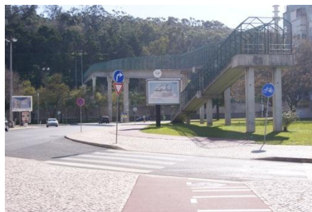
Fig. 02 41 – Fotografia da Ponte Pedonal para Monsanto. Fonte: IA.
